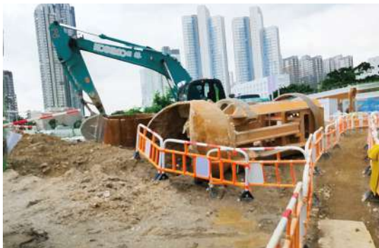
圖34-通道的護欄與起重機或其他可能移動的機器的任何部分之間的距離至少為600毫米
