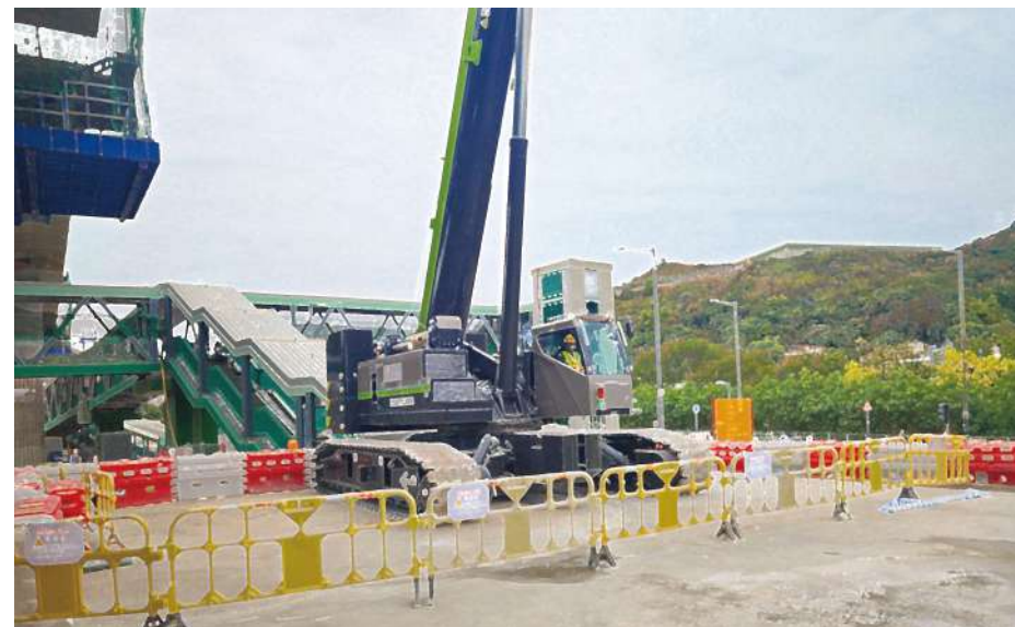
圖17-吊運區域，包括所有起重設備及其部件的移動範圍，均設有足夠的圍封
