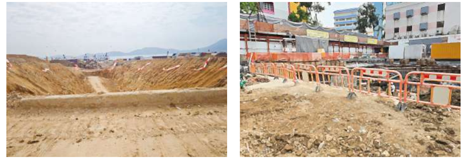
圖31-在堤圍、挖掘工程及孔洞的邊緣設置有臨時圍欄和警告，以防止翻滾風險
