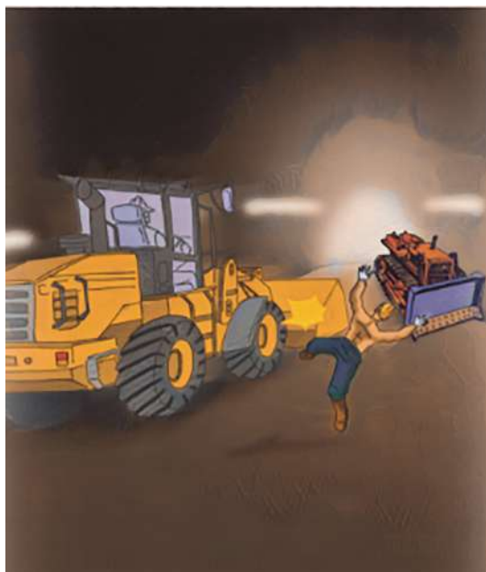
圖39—一名地盤管工在建築中的隧道被一輛輪式搬土機撞倒的個案
