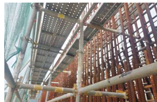
圖10-棚架能夠覆蓋所有工作地點
