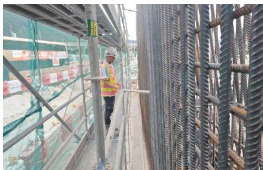
圖9-設置連牆器和支撐斜撐
