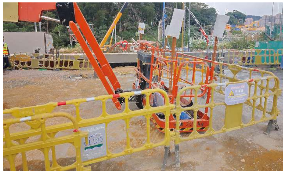
圖7-用於天花板作業的動力操作升降工作台設置頂部防撞保護
