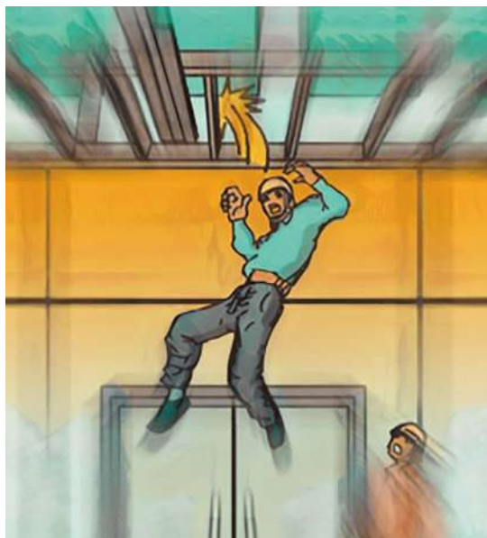
圖38—一名玻璃嵌板安裝工人從簷篷上的框架間隙墮下的個案
