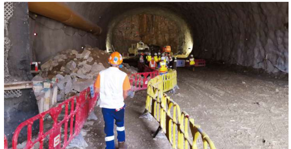
圖32-行人通道已正確劃定並設置適當的圍欄，為工人提供保護
