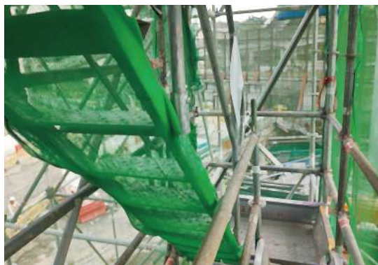
圖12-安全網已設置且沒有破損
