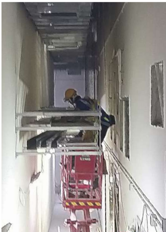
圖14-懸吊式電線架阻礙工友進行安裝工序
