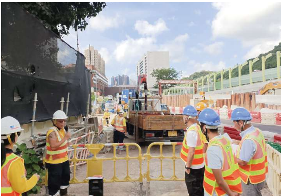
圖27-所有機械操作員、訊號員和其他相關工人均接受了有關交通安排和使用負荷物移動機械的內部安全指示，包括信號、負荷圖和使用手冊
