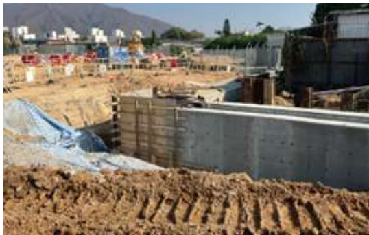
圖30-未有提供合適及安全的通道給工友到泥坑工作
