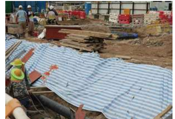
圖34-建築材料堆放於工友工作中的泥坑邊
