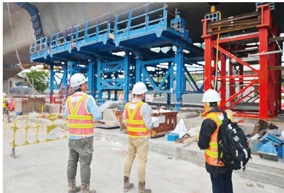
圖37-任合資格的人員檢查塔式通架的結構完整性並正式記錄檢查結果為安全可用
