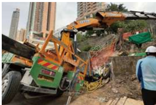
圖18-因地面不穩而導致吊機失去平衡
